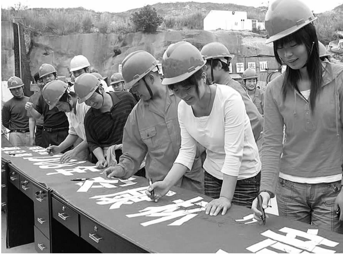
三月三十日,十五局集团大亚湾项目部在隧道施工工地举行了以“提高安全健康素质,实现安全健康科学发展”为主题的“安康杯”竞赛活动启动仪式,使项目全体职工进一步增强了安全与健康意识。图为大亚湾项目部职工在“安康杯”横幅上签字。孙喜胜 丛建伟 摄
