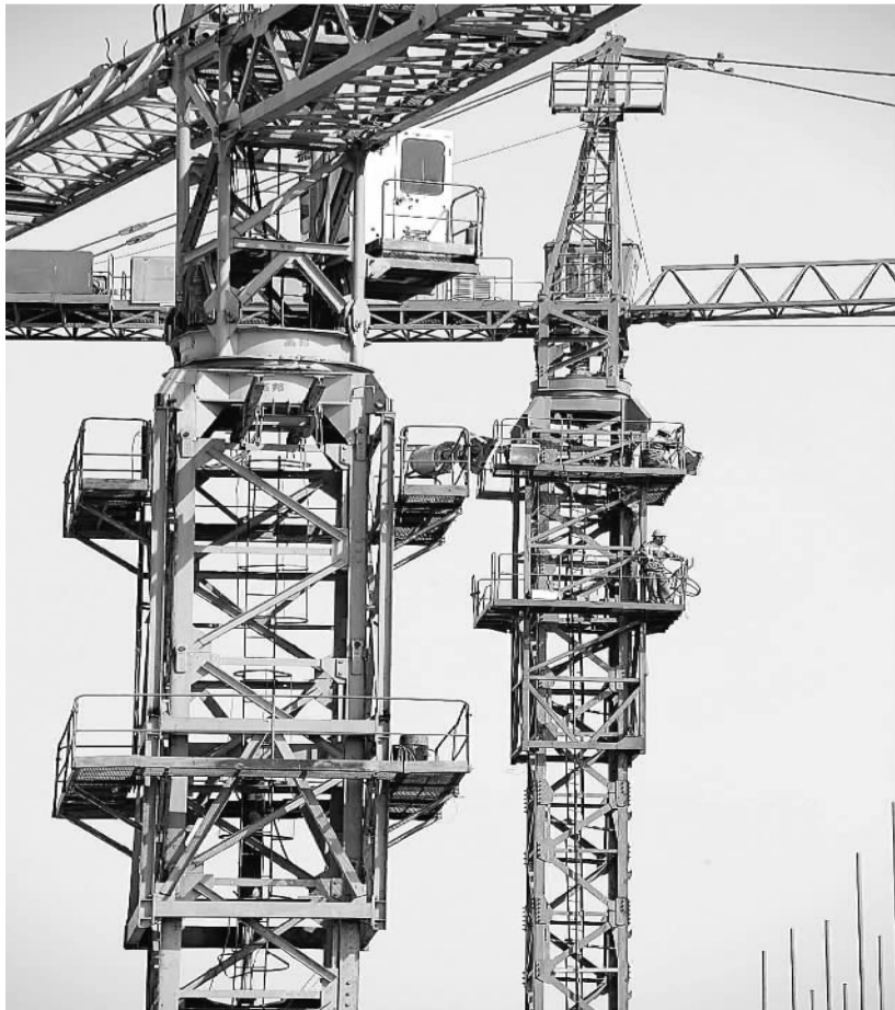
由十六局集团公司、天津电建等单位承建的天津东北郊热电厂项目,目前施工进度顺利。该项目是华北地区第一个集脱硫、脱硝、烟塔合一等先进电力环保技术于一体的绿色环保工程,目前已完成全部工程量的70%以上,多次受到业主好评。朱洪山 郭伟 摄
