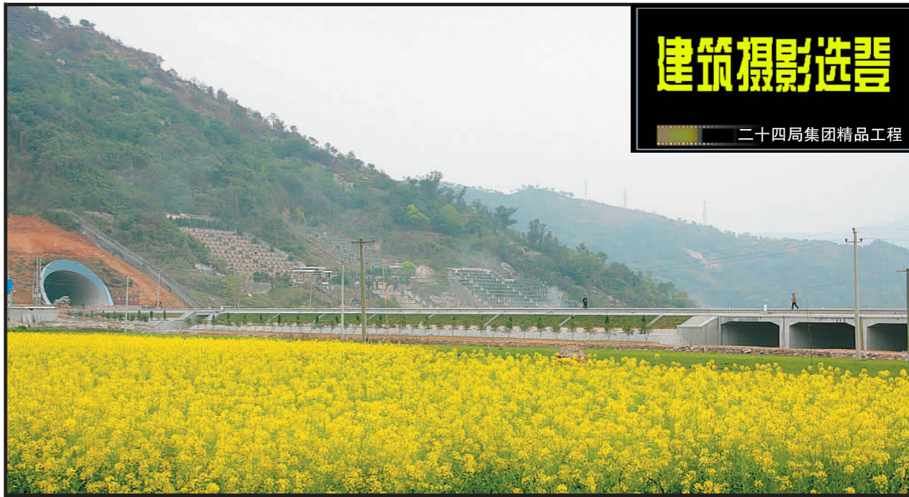
▲温福铁路路基绿化样板工程 刘建国 章恒金摄
