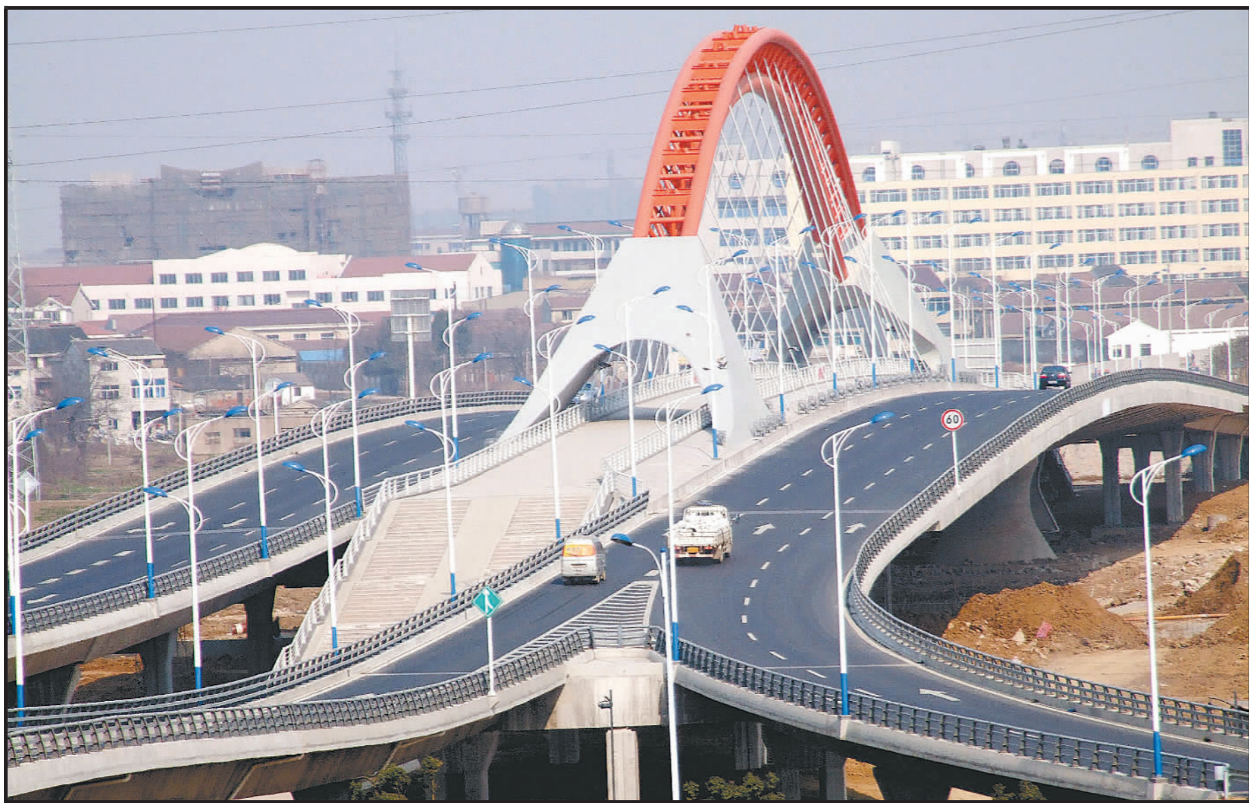
▲常州青洋大桥 吴炳森摄
