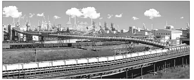
▲天津港散货物流中心长廊胶带机工程
