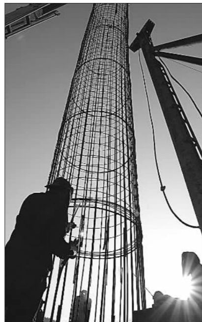
▲寺前特大桥的高桥墩施工
