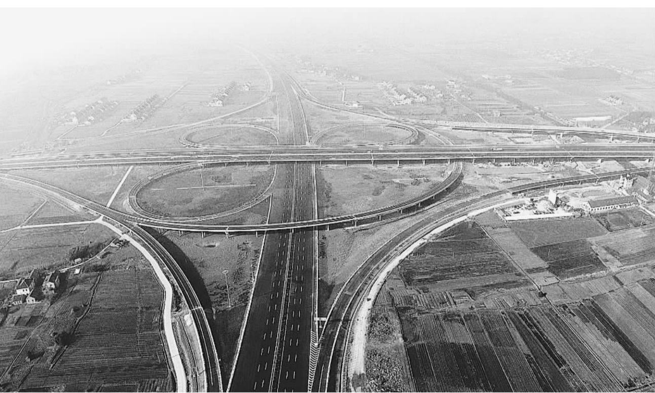
中嘉湖高速公路是“长三角经济区”通往上海的五大通道之一,在嘉兴与乍嘉苏高速公路相交,形成了浙江省第二大互通枢纽——观音桥互通枢纽。担负施工任务的二十一局集团三公司中嘉湖项目部,以建设“景观路、环保路、生态路”为施工理念,打造“中国铁建”品牌。图为观音桥互通枢纽全景。
