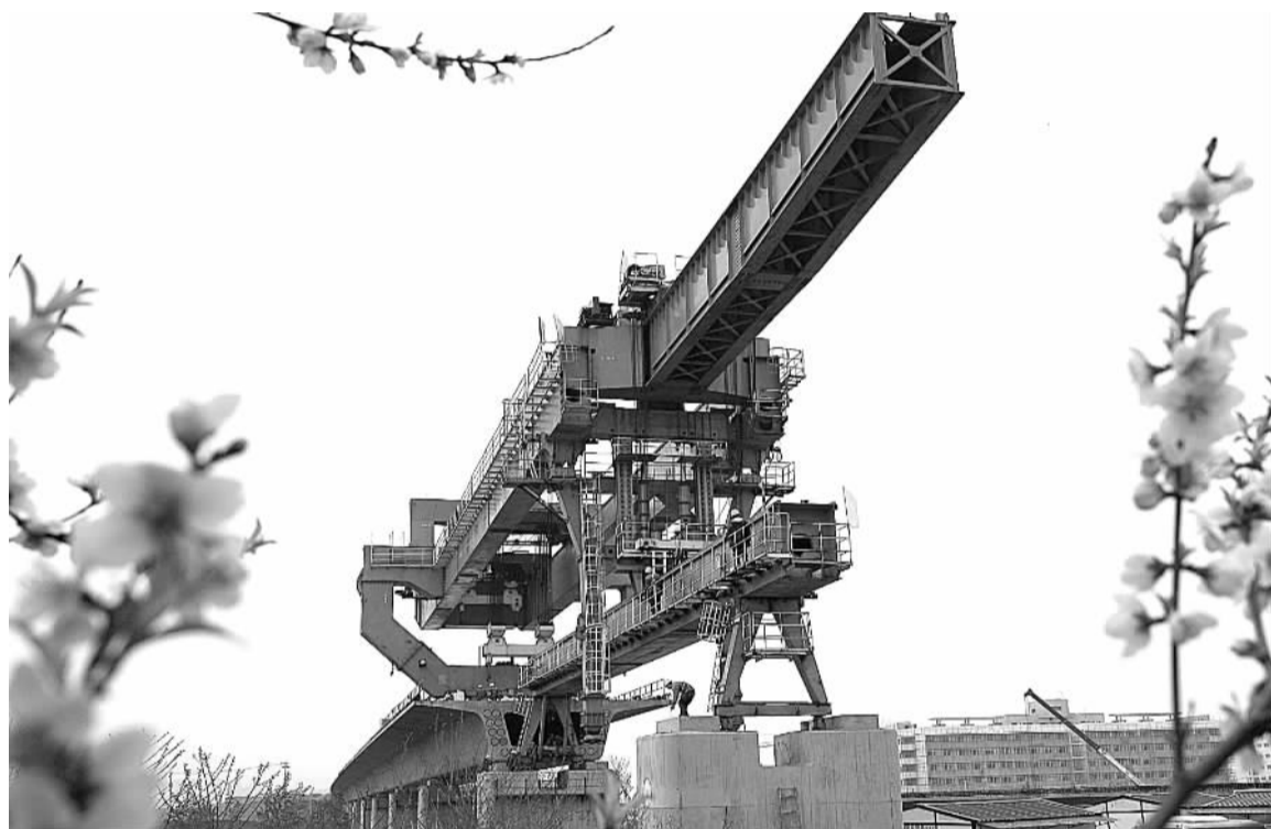
担负武广客运专线七百多孔九百吨整体箱梁生产任务的十八局集团一公司,广泛推广应用新技术、新材料、新工艺,攻克了多项技术难题,在确保质量全面创优的同时,也加快了施工进度。图为架梁时的场面。白树民摄
