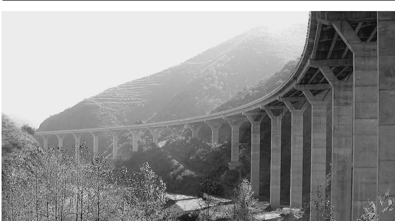
十二局集团三公司在云南省昭待高速公路施工中,克服沟谷密度大、地质条件差等困难,科学组织施工,在历次安全、质量、进度评比中均获得优胜施工单位。图为已建成通车的头道河高架桥雄姿。 冯学亮 李军保 摄
