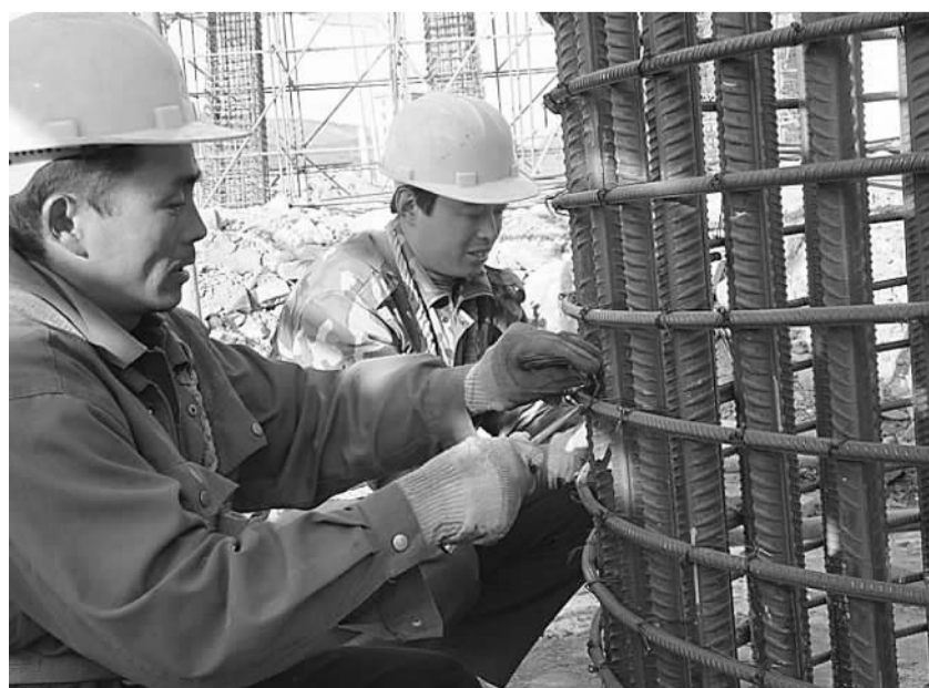
距北京奥运会还有120多天,由十七局集团等15家承担施工的北京市西 六环公路良(乡)寨(口)段奥运配套工程,现已进入收尾阶段。图为两位农 民工在认真地绑扎钢筋。 申宝华 摄
