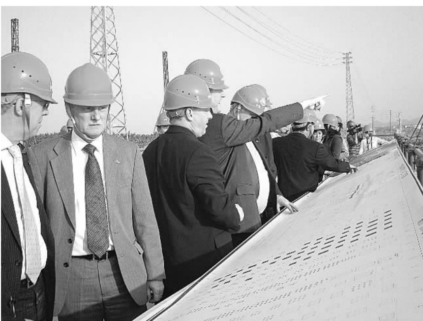
近日,英国铁路工业代表团一行9人,在广铁集团广州新客站工程建设指挥部蔡慧华总工程师的陪同下,到二十二局集团广州新客站工程工地进行了实地考察。图为英国铁路工业代表团一行9人,在观摩台上对施工工地观看广州新客站工程建设工地。 杨建国 摄
